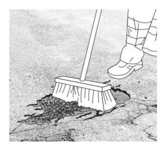
1. EASYPHALT® muss vor dem Einbau grundsätzlich auf Raumtemperatur gebracht werden. Vor dem Einbau ist der Untergrund mit einem Straßenbesen zu reinigen.
